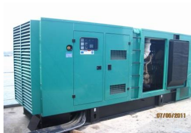
(ข) เครื่องกำเนิดไฟฟ้าชนิดตู้ ครอบเก็บเสียง
