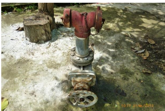
ลักษณะของหัวจ่ายน้ำดับเพลิงที่มีติดตั้งใช้งานทั่วไป
