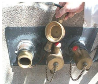
(ข) หัวรับน้ำดับเพลิงชนิดข้อต่อสวมเร็วขนาด ๒½
