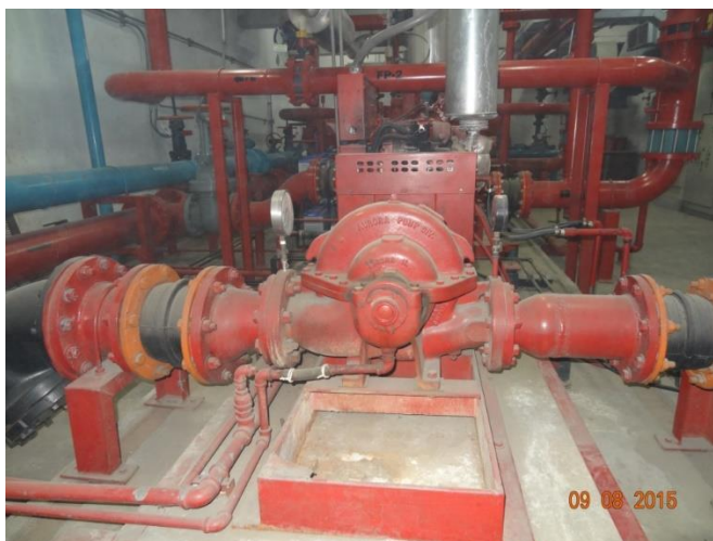
รูปเครื่องสูบน้ำดับเพลิงชนิดแรงเหวี่ยงหนีศูนย์กลางแบบ Horizontal Split Case
