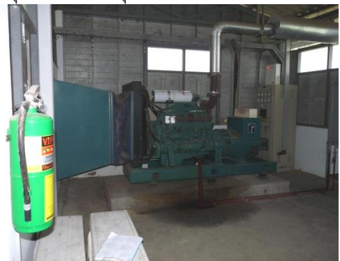
ติดตั้งบนฐานแท่นเครื่อง(คอนกรีต)
