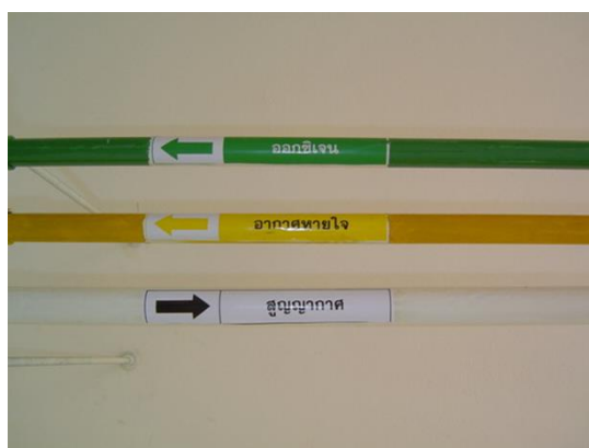
ต้องทาสีตามชนิดของก๊าซในเส้นท่อและลูกศรบอกทิศทางการไหล Oxygen เขียวมรกต , Nitrous oxide น้ำเงิน, อากาศทางการแพทย์ เหลือง
