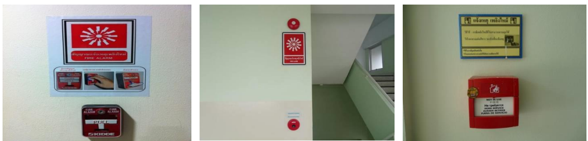
รูปตัวอย่างการติดป้ายสัญลักษณ์เพื่อระบุตำแหน่งของอุปกรณ์แจ้งเหตุด้วยมือ
