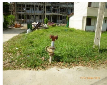
ลักษณะของหัวจ่ายน้ำดับเพลิงที่มีติดตั้งใช้งานทั่วไป
