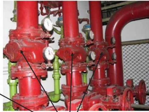
วาล์วควบคุมระบบท่อเปียก (Wet Pipe Alarm Valve)
