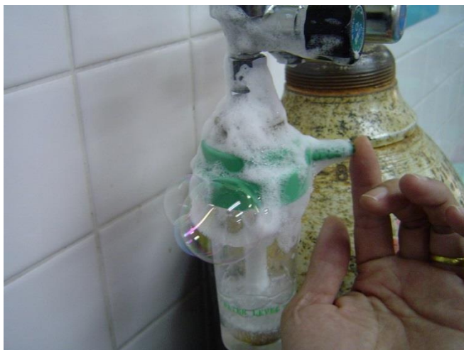
การตรวจสอบรอยรั่วข้อต่อโดยใช้น้ำฟองสบู่
