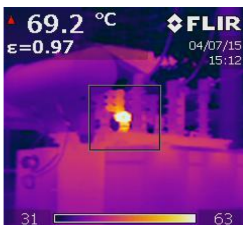
รูปแสดงจุดร้อนที่เกิดขึ้นที่หม้อแปลงไฟฟ้า
