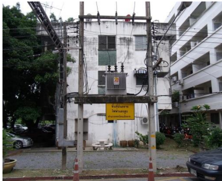
ติดตั้งบนจันทัน
