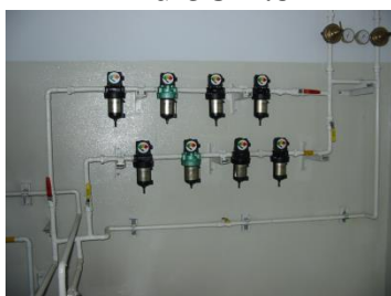
กรองละเอียด ๐.๓ Micron กรองแยกละอองน้ำ ๐.๑ Micron กรองกลิ่น ๙๕ %
