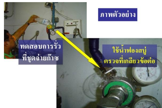
การตรวจสอบรอยรั่วบริเวณข้อต่อเกลียวทั้งระบบโดยใช้น้ำฟองสบู่
