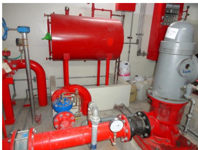
รูปเครื่องสูบน้ำดับเพลิงแบบเทอร์ไบน์แนวตั้ง (Vertical Turbine Pump)
